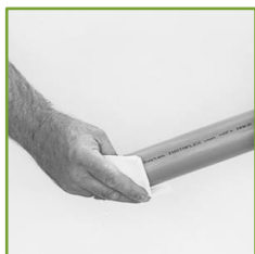
02. Reinig de mediumbuis met behulp van PB reiniger en tissues en maak cirkelvormige bewegingen over het gehele lasoppervlak. Zorg ervoor dat eventuele bedrukkingen op de mediumbuis op de juiste wijze wordt verwijderd.
