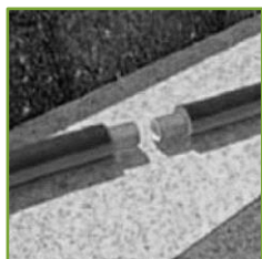
01. Plaats de te lassen buizen in een spanningsvrije positie.
