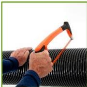
**01.** Falls nötig, kürzen Sie das TQ Air-Rohr mit einer Metallsäge. Folgen Sie dabei rundum derselben Furche des gewellten Mantels.
