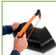
**02.** Um einen 45°-Bogen zu erhalten, sägen Sie einen vorgedämmten TQ-Air Bogen mit 90° in der Mitte durch.
