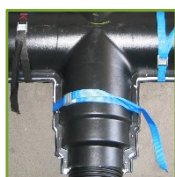
06. Placer den øverste halvdel af skallen. Brug stropper til at fastholde og lette håndteringen.
