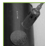
10. Når PUR-skumningsprocessen er afsluttet, kan du fjerne udluftningsproppen. Påfør tætningslap med varme ved hjælp af en gas brænder.
