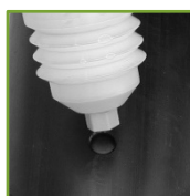
08. Bland 2komponent PUR-skum ifølge vedhæftet instruktion, og påfyld i det for borede hul på den øverste T-halvskal.
