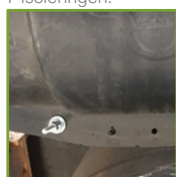
07. Monter møtrikker, skiver og bolte for at samle de to halvskaller sikkert. Start montagen fra midten af T-stykket og arbejdt udad.
