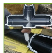
05. Påfør klæbemiddel på den nederste halvdel af T og placer den under afgreningen. Påfør derefter yderligere klæbemiddel, hvor den nederste halvdel, og den øverste halvdel skal samles.
