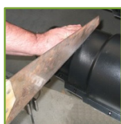
01. Afkort til den ønskede kappediameter (til OD160 / 200 kapperør).
