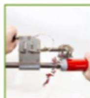
Gratter la surface du tube dans le sens des aiguilles d'une montre en tournant doucement l'appareil. Ne pas pousser. S'assurer que la couche EVOH enlevée ne se mette pas entre le couteau et le tube.
